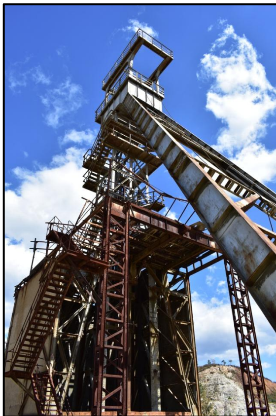
Vista de detalle del castillete del pozo Don Alfonso.
