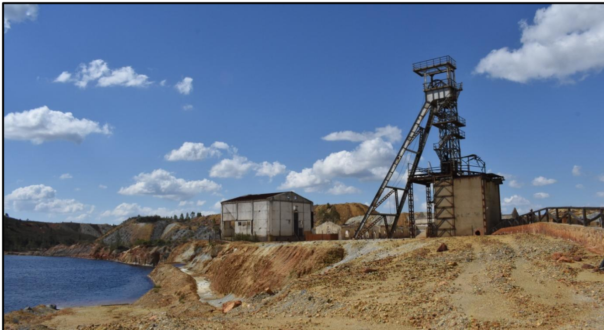
Vista general del castillete del pozo Don Alfonso.
