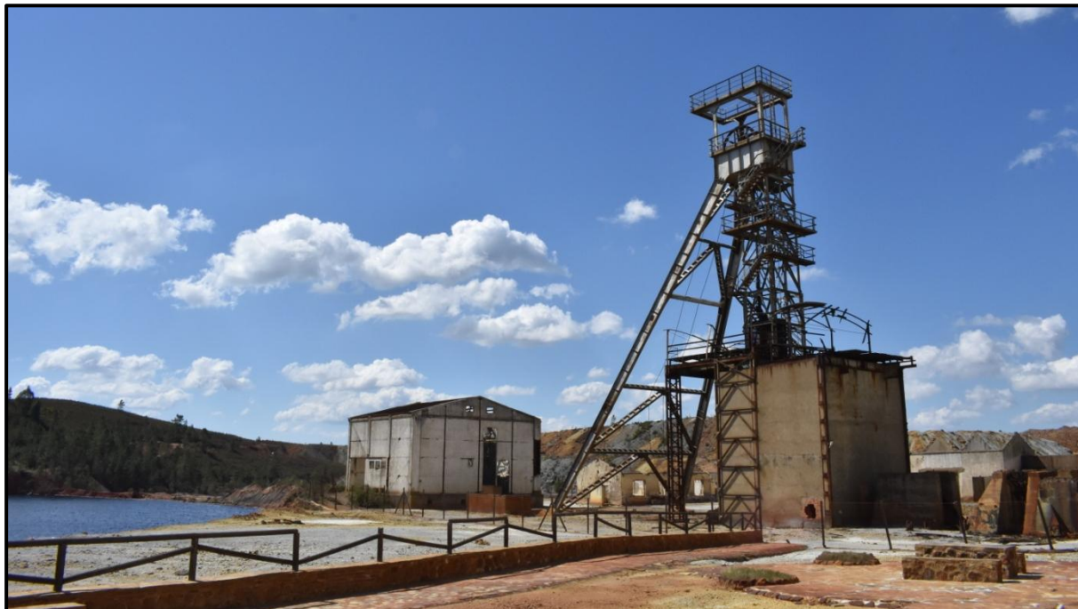
Vista general del castillete del pozo Don Alfonso.
