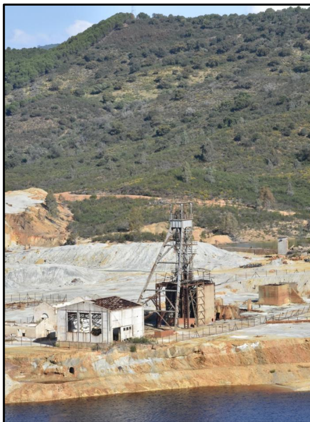
Vista general del castillete del pozo Don Alfonso.
